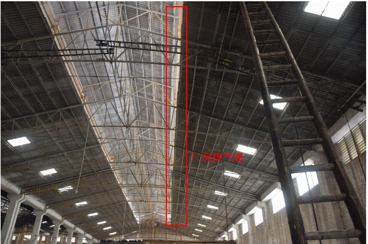
图五 厂房排气窗
