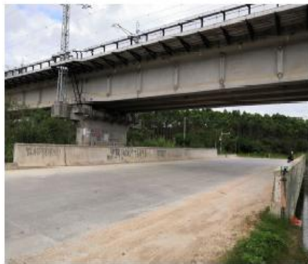
K150+050 桥梁（下穿深茂铁路）
