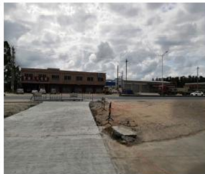
项目终点交叉口
