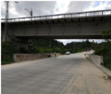
下穿深茂铁路桥梁（利用）
